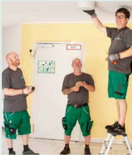
Pascal Schulte, Markus Bartlog und Reik Luthe bei der Kontrolle im Treppenhaus.
