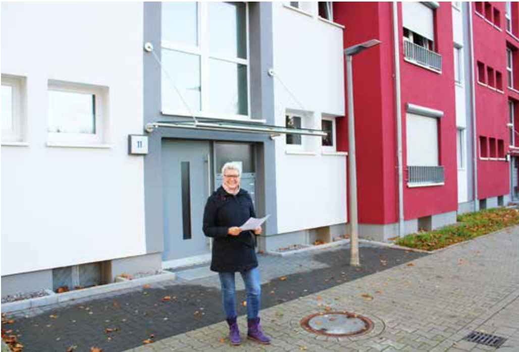
Sandra Ewald im neuen Quartier Rockwoolstraße/Kampstraße, das ein echter Blickfang geworden ist.
